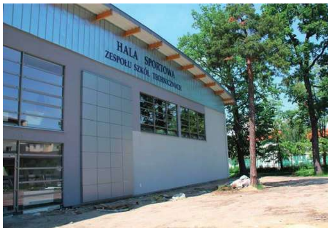
Nowa hala sportowa przy ZST w Puławach – prace na ukończeniu
