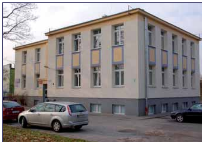
Elewacja Przychodni nr 1 odnowiona przy wsparciu Miasta
