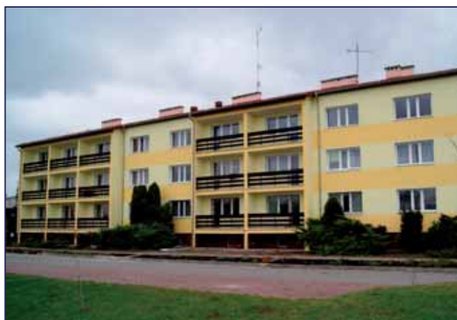
Wyremontowany internat ZS w Żyrzynie
