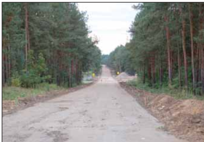
Etapy przebudowy drogi
