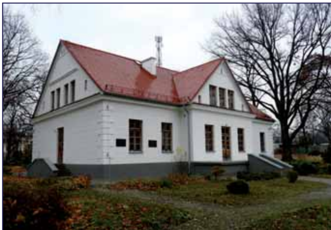
Wyremontowany budynek MDK w Puławach
