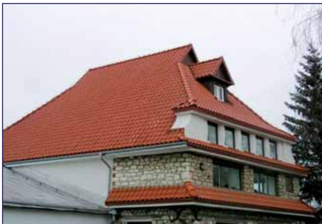
Wyremontowany dach internaty ZS w Kazimierzu Dolnym
