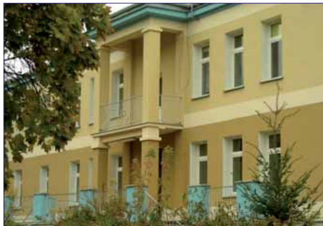
Pawilon C szpitala w Puławach po termomodernizacji
