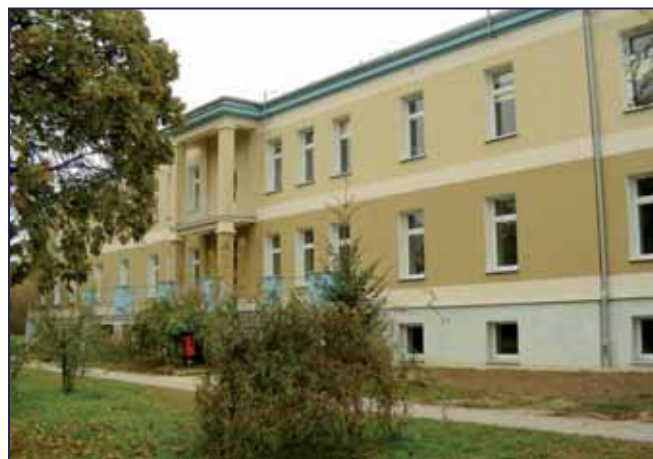
Termomodernizacja pawilonu C szpitala
