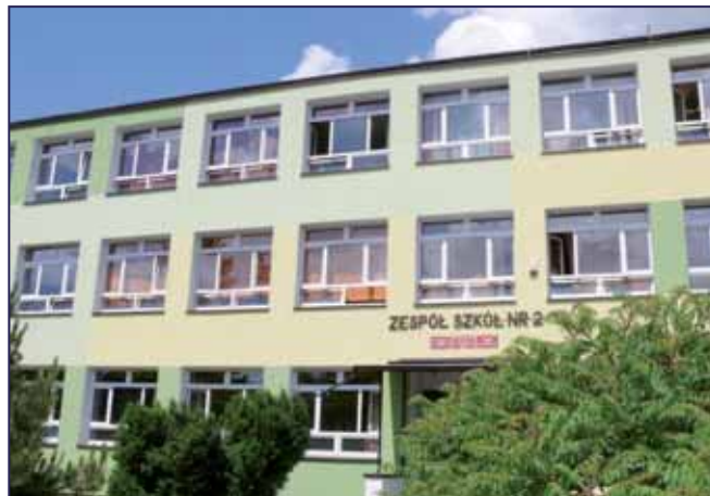
Budynek ZS nr 2 w Puławach po termomodernizacji
