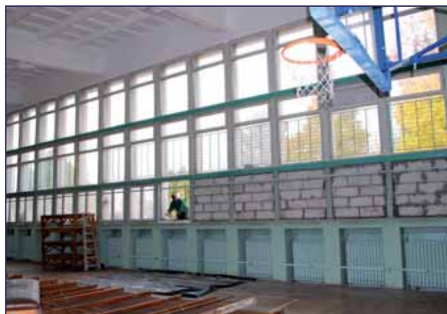
Termomodernizacja sali gimnastycznej ZS nr 2 w Puławach
