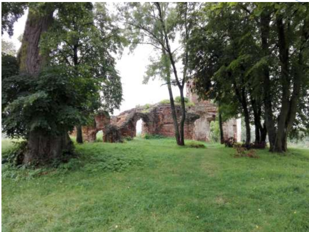
Ryc. nr 1 Ruiny Pałacu w Zawieprzycach.
