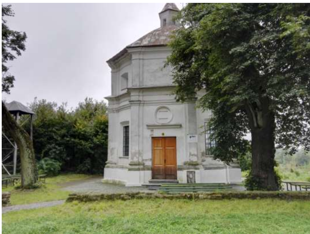
Ryc. nr 2 Ruiny Pałacu w Zawieprzycach - kaplica pałacowa.
