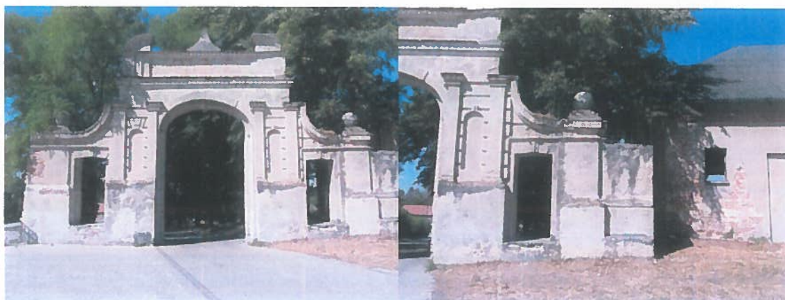
Fot. 3. Elewacja południowa.
