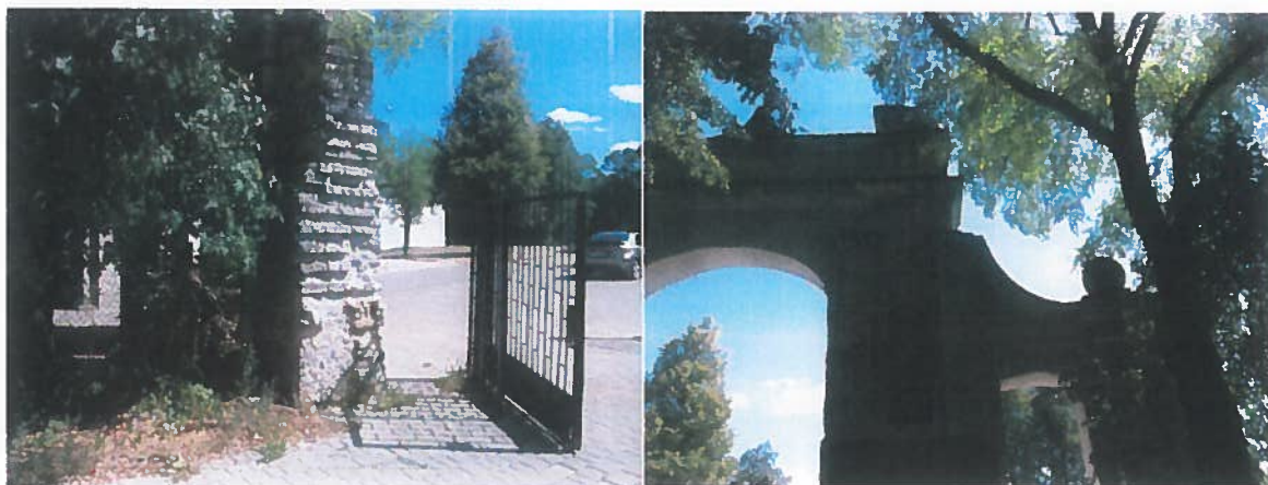
Fot. 5. Elewacja zachodnia i północna.
