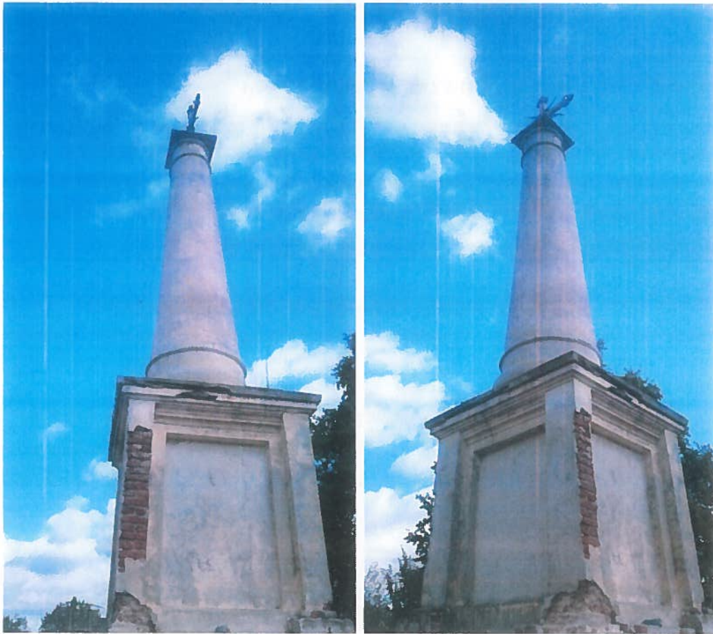
Fot. 1. Elewacja południowa i południowo-zachodnia.
