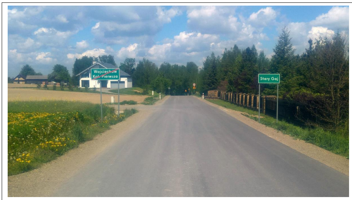
Fot. 14. Przebudowa drogi powiatowej nr 2235L Wąwolnica – Stary Gaj na terenie Gminy Wojciechów.
