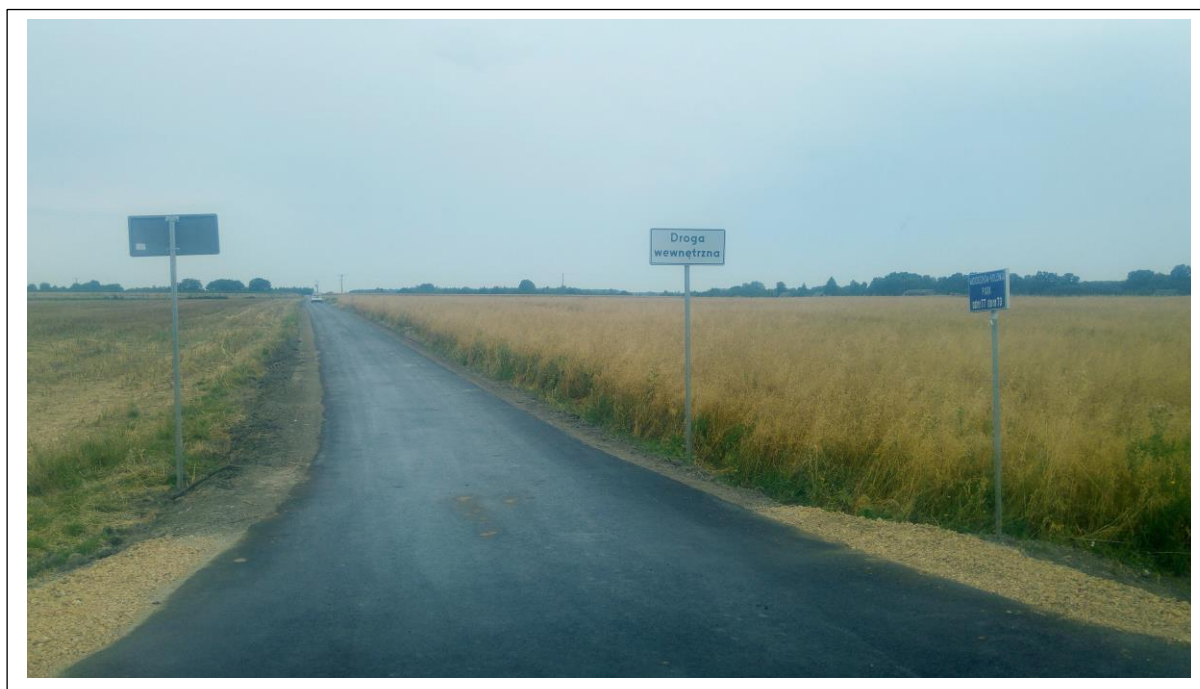
Fot. 11. Przebudowa drogi dojazdowej do gruntów w obrębie miejscowości Wojciechów Kolonia Piąta (działka nr ew. 24).
