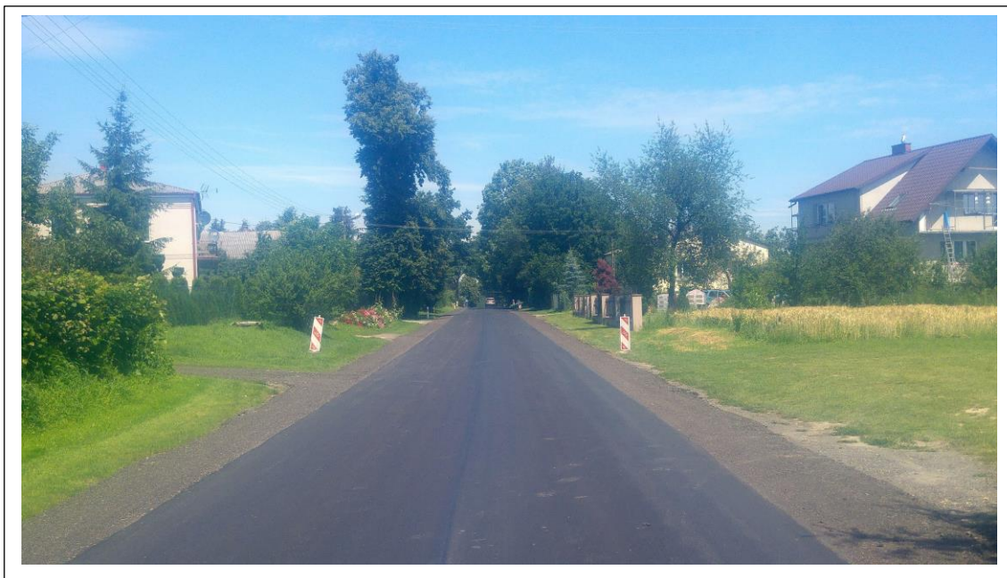
Fot. 13. Droga wojewódzka nr 827 po wykonaniu remontu nawierzchni w Wojciechowie Kolonii Piątej.
