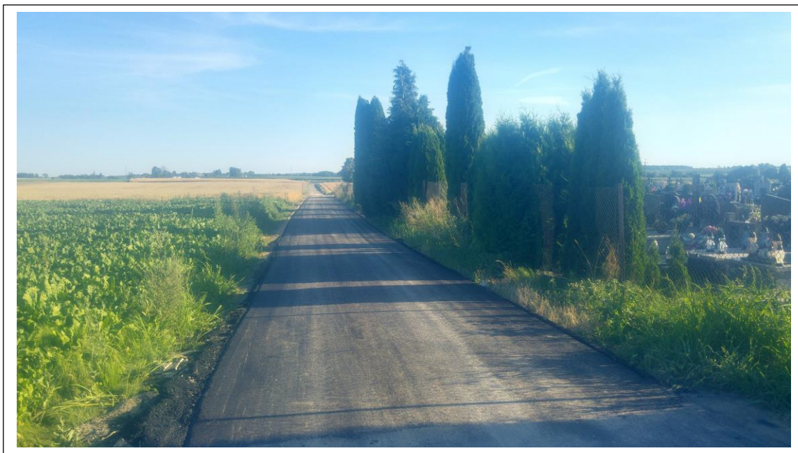
Fot. 6. Wybudowany odcinek drogi do cmentarza parafii Łubki.
