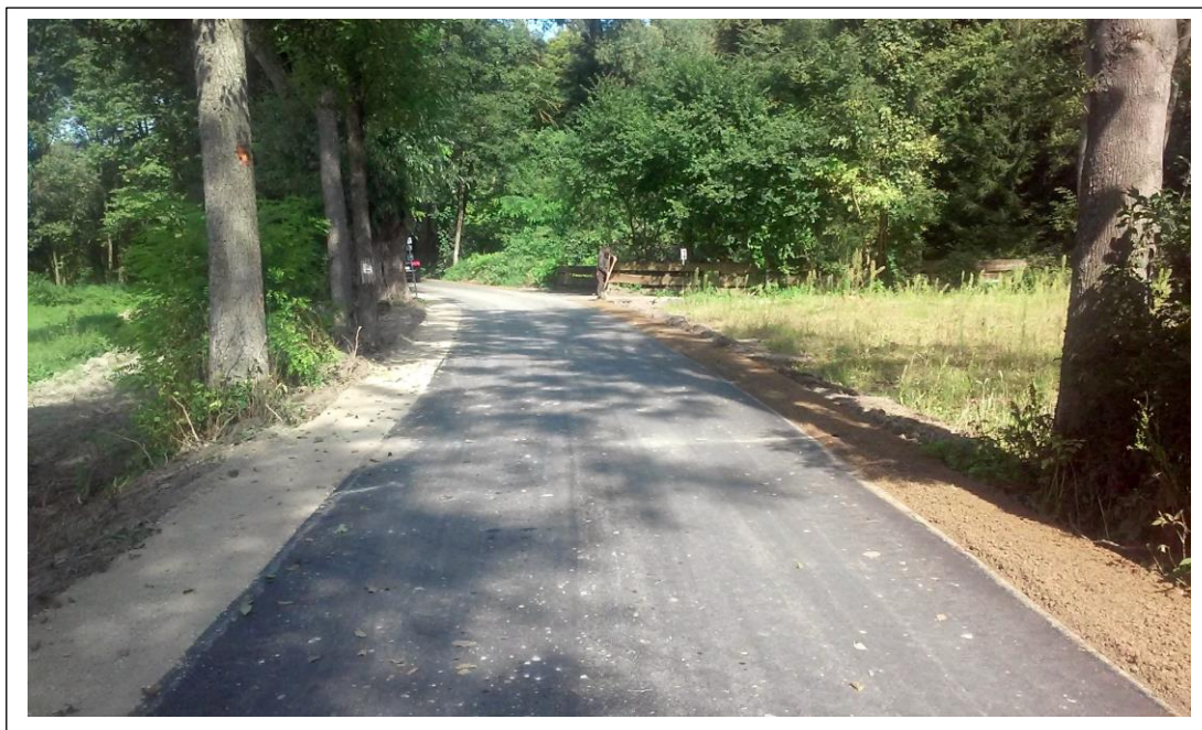
Fot. 18. Przebudowany odcinek drogi gminnej nr 106910L i drogi wewnętrznej położonej na działce ewidencyjnej nr 543/1 w miejscowości Nowy Gaj na długości 800 m.
