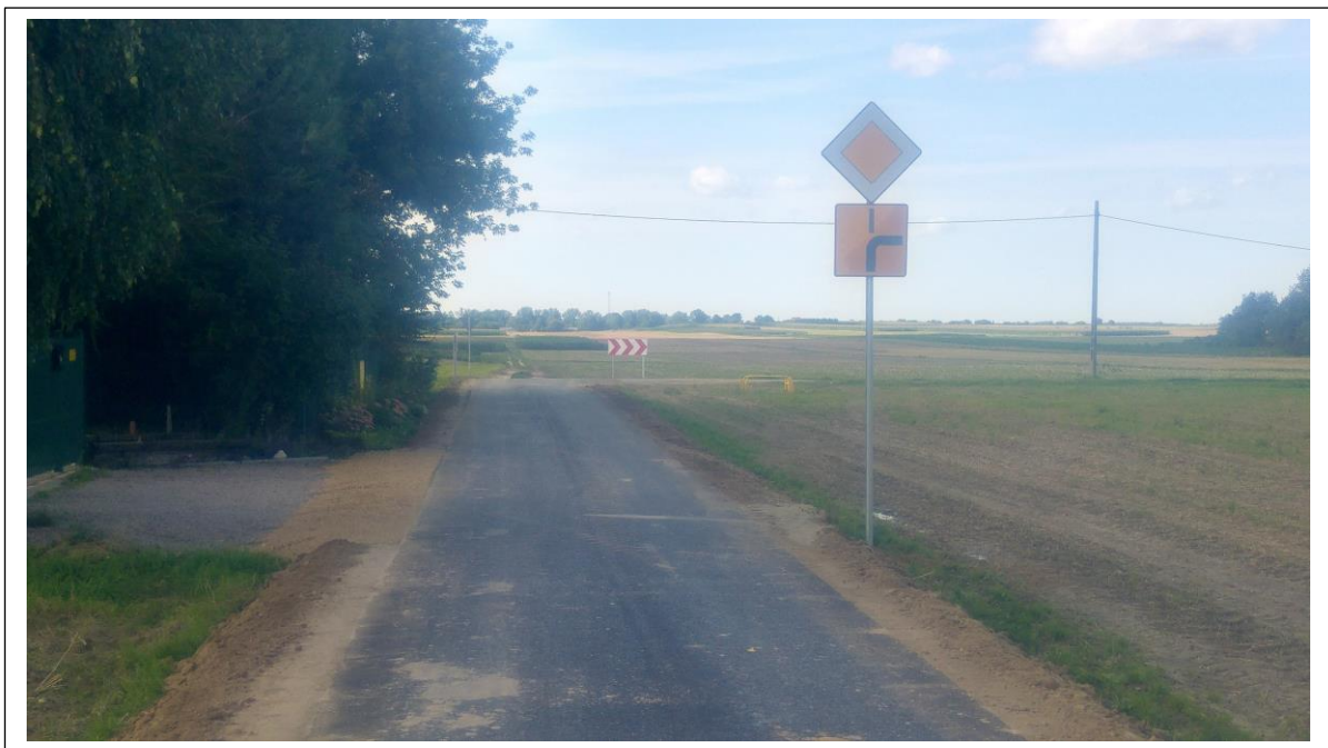
Fot. 19. Przebudowany odcinek drogi gminnej nr 106930L (Wojciechów – Tomaszówka – droga powiatowa 2233L) na działce nr ewid. 153 (obręb Stasin Kolonia) i działce nr ewid. 989 (obręb Wojciechów) na długości 700 m.
