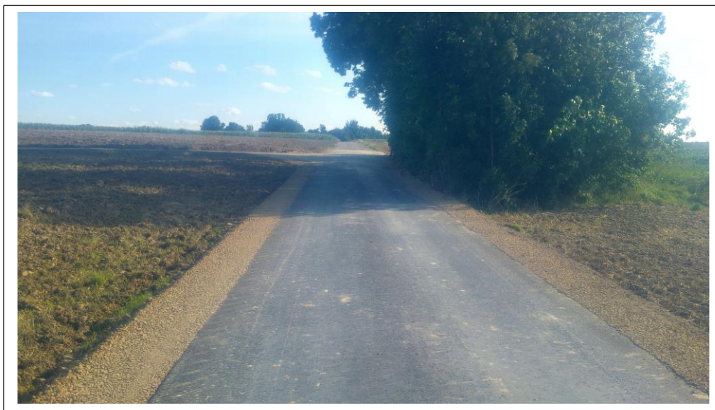
Fot. 8. Przebudowane odcinki dróg gminnych nr 106913L (działka nr 1575) i nr 106914L (działka 818) w miejscowości Wojciechów na długości 800 m.
