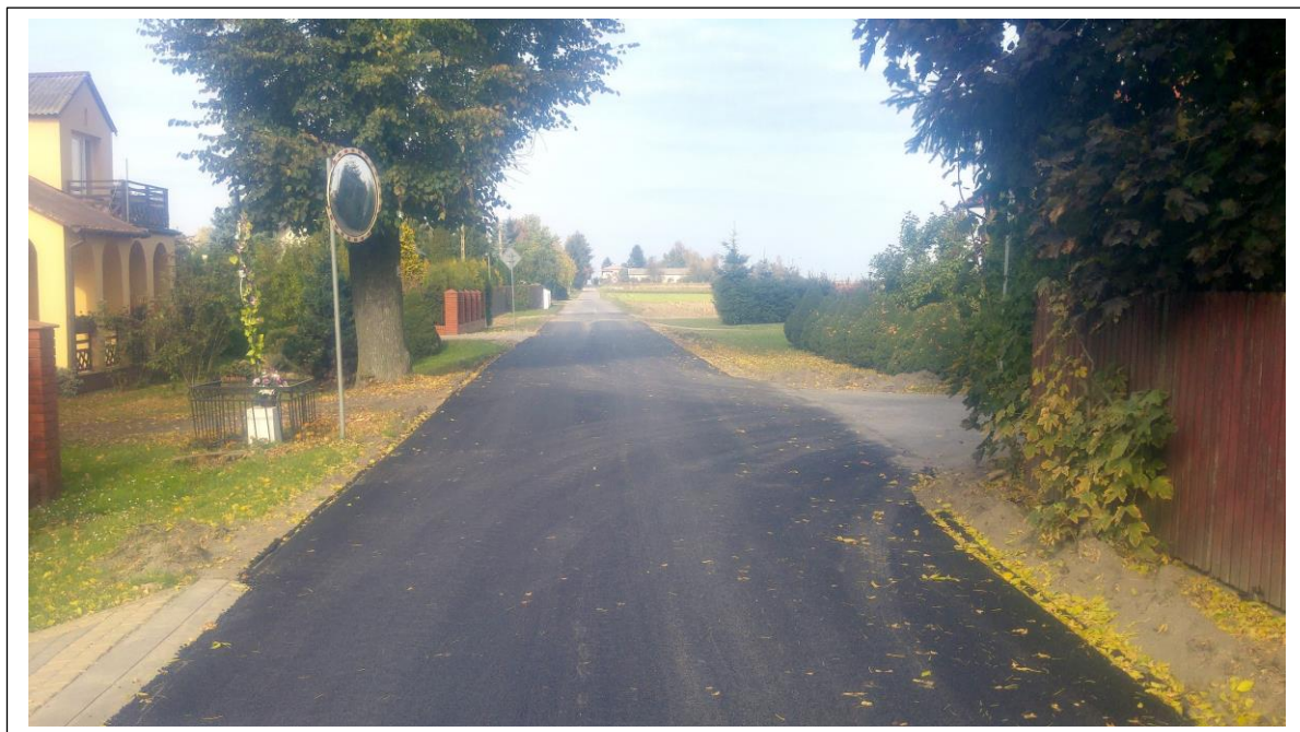
Fot. 11. Przebudowany odcinek drogi gminnej nr 106913L w miejscowości Wojciechów Kolonia Pierwsza na długości 150 m.
