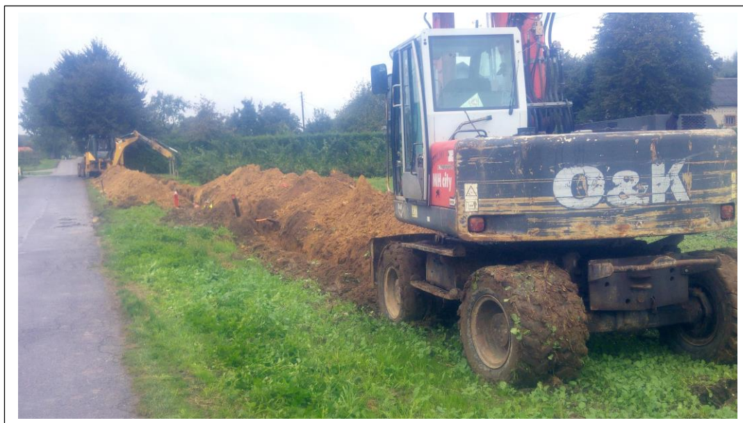
Fot. 21. Budowa sieci wodociągowej rozdzielczej wraz z przyłączami w miejscowościach Maszki, Maszki k/Wojciechowa, Palikije Drugie, gm. Wojciechów o długości 6,672 km.
