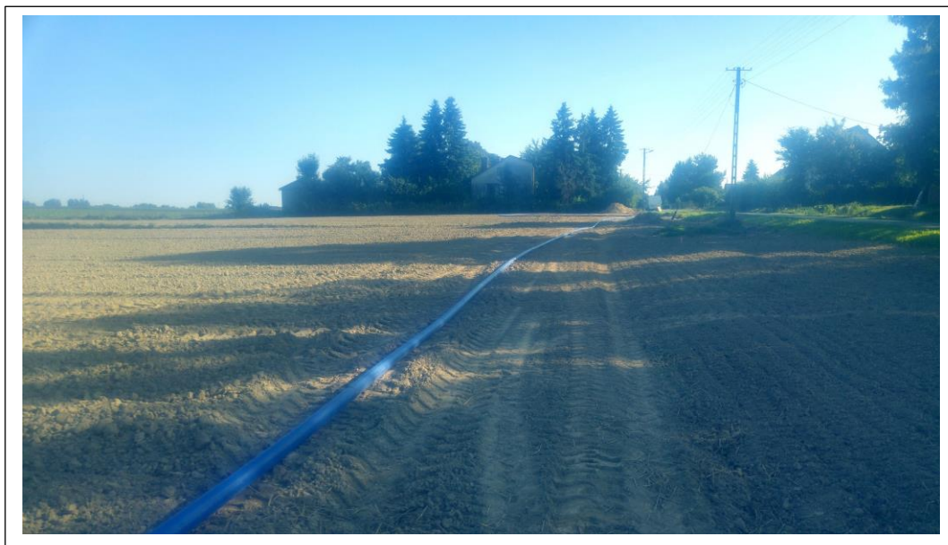
Fot. 20. Budowa sieci wodociągowej rozdzielczej wraz z przyłączami o długości 4,669 km w miejscowościach Wojciechów Kolonia Piąta i Wojciechów Kolonia Pierwsza.
