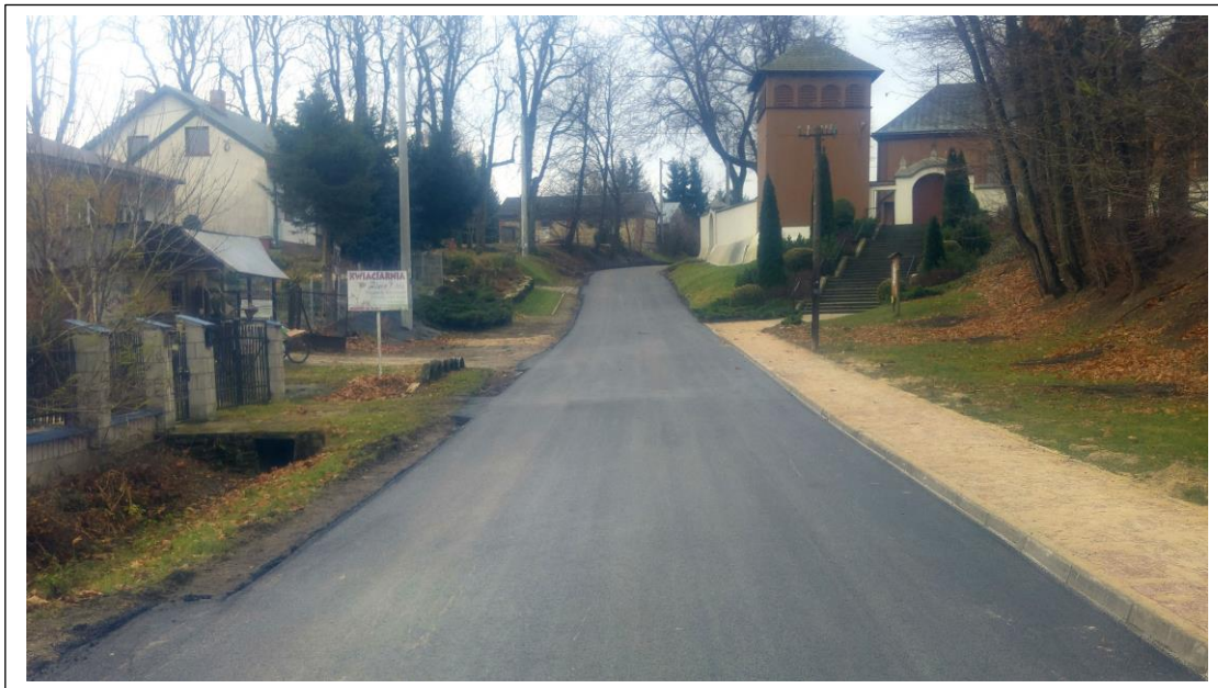
Fot. 9. Przebudowany odcinek drogi gminnej nr 106916L w miejscowości Wojciechów na długości 500 m.
