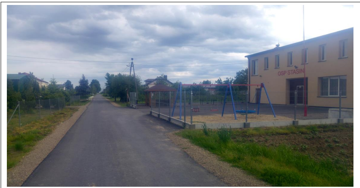
Fot. 8. Przebudowa drogi gminnej nr 106928L (dz. nr 155) oraz drogi gminnej nr 106929L (dz. nr 158) w miejscowości Stasin.
