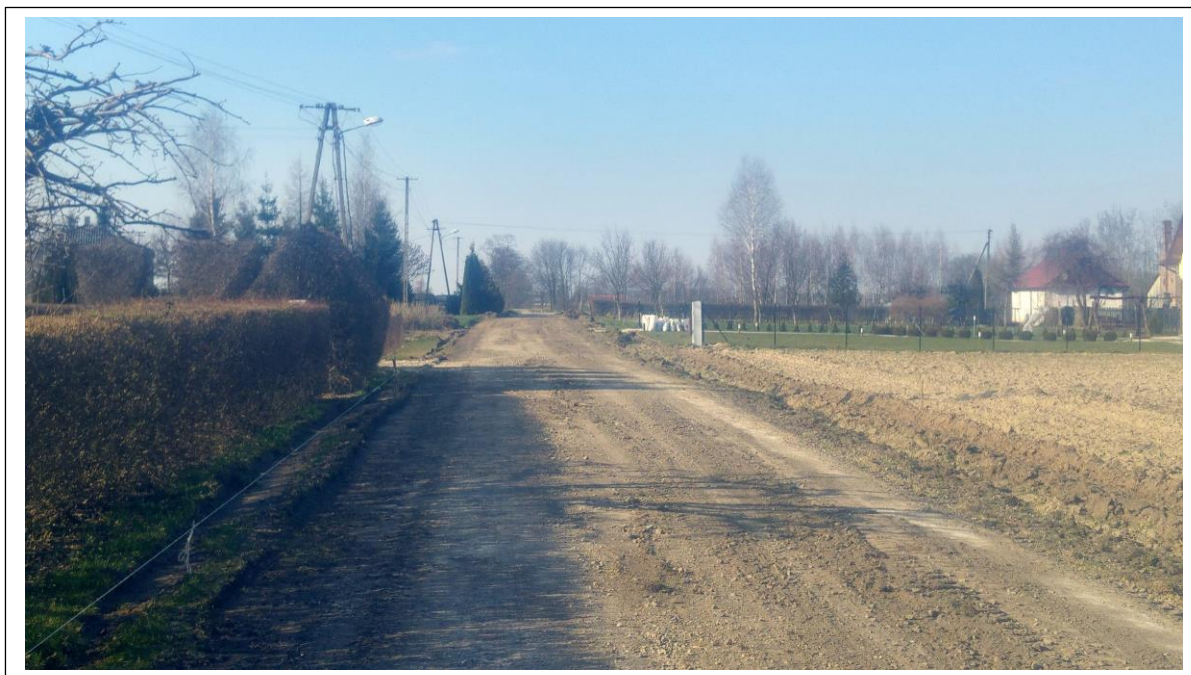
Fot. 14. Droga gminna nr 106903L w miejscowości Szczuczki.
