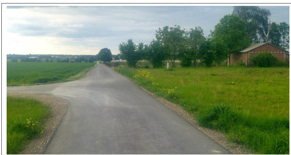
Fot. 9. Przebudowa drogi gminnej nr 106924L (dz. nr 719) w miejscowości Palikije Pierwsze.
