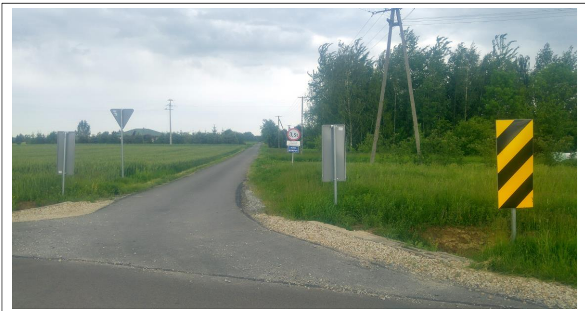
Fot. 3. Przebudowa drogi wewnętrznej (działka nr 392) w miejscowości Miłocin.
