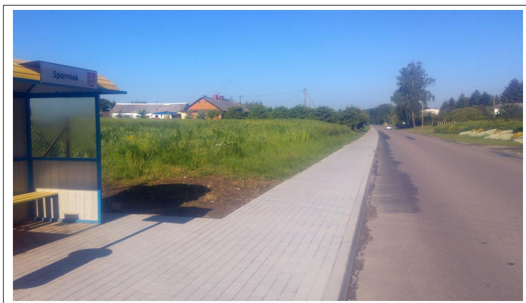
Fot. 5. Budowa chodnika przy drodze powiatowej nr 2229L (Wojciechów – Palikije – Sporniak – Motycz) w miejscowości Sporniak.
