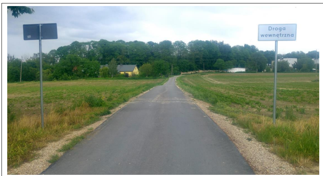
Fot. 4. Przebudowa drogi na działce wewnętrznej nr 1/6 w miejscowości Palikije Drugie.
