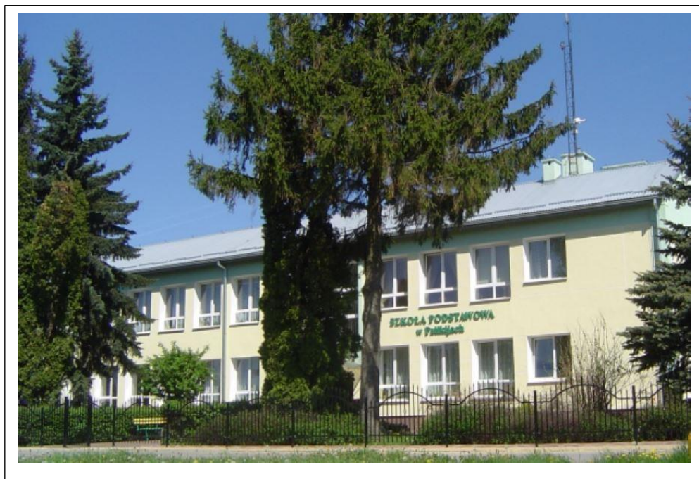
Fot. 31. Budynek Szkoły Podstawowej w Palikijach.
