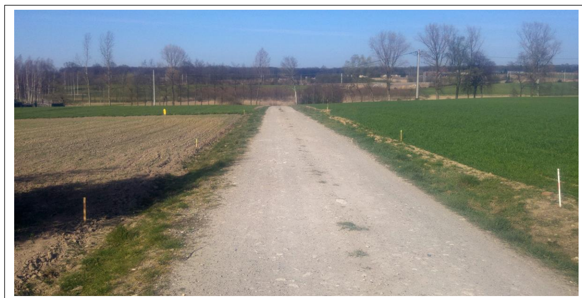
Fot. 15. Droga wewnętrzna działka nr 292 w miejscowości Palikije Pierwsze.
