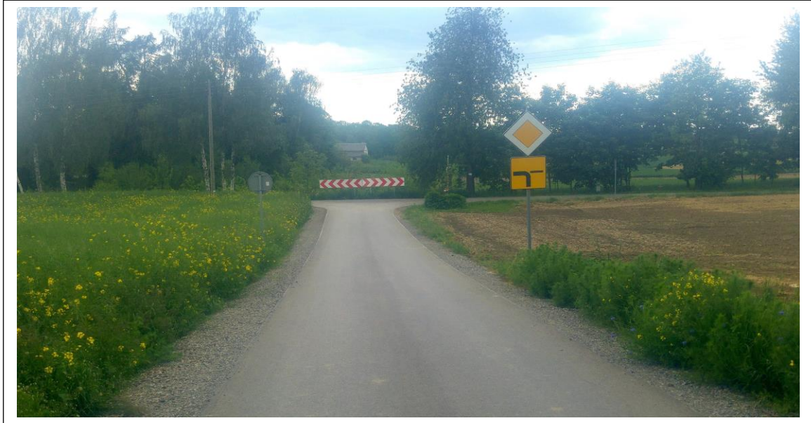
Fot. 7. Przebudowa drogi gminnej nr 106917L w miejscowości Maszki, gm. Wojciechów na odcinku 990 m (na działkach nr 60 i 365).
