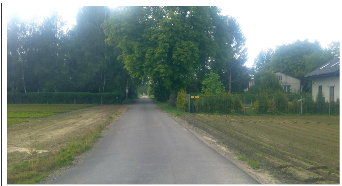
Fot. 2. Przebudowa drogi gminnej nr 106921L w miejscowości Miłocin.
