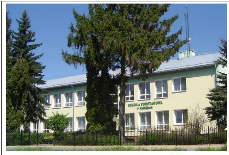
Fot. 30. Budynek Szkoły Podstawowej w Palikijach.
