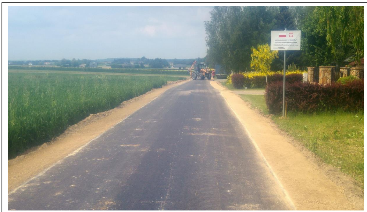
Fot. 5. Przebudowany odcinek drogi wewnętrznej (dz. nr ewid. 474) w miejscowości Palikije Pierwsze na długości 770 m.
