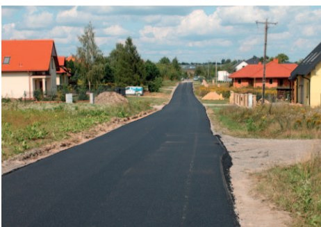
Droga w Rudniku
