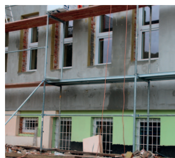
Termomodernizacja SP w Sobianowicach
