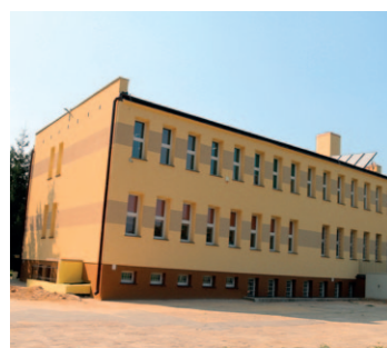
Termomodernizacja SP w Sobianowicach
