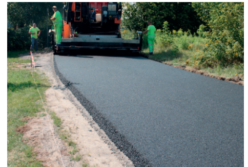
Droga w Rudniku
