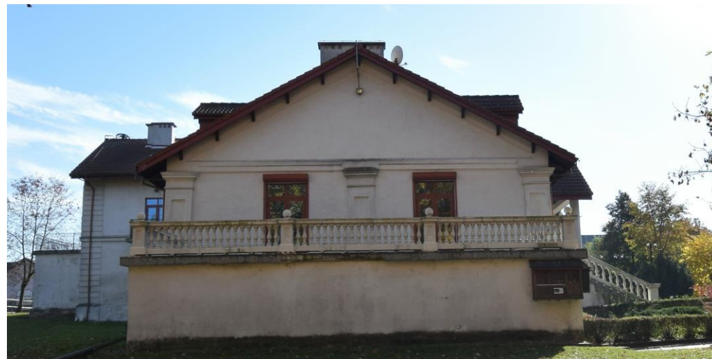
Widok od północnego zachodu
