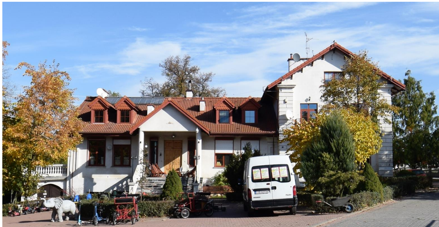
Widok od południowego zachodu
