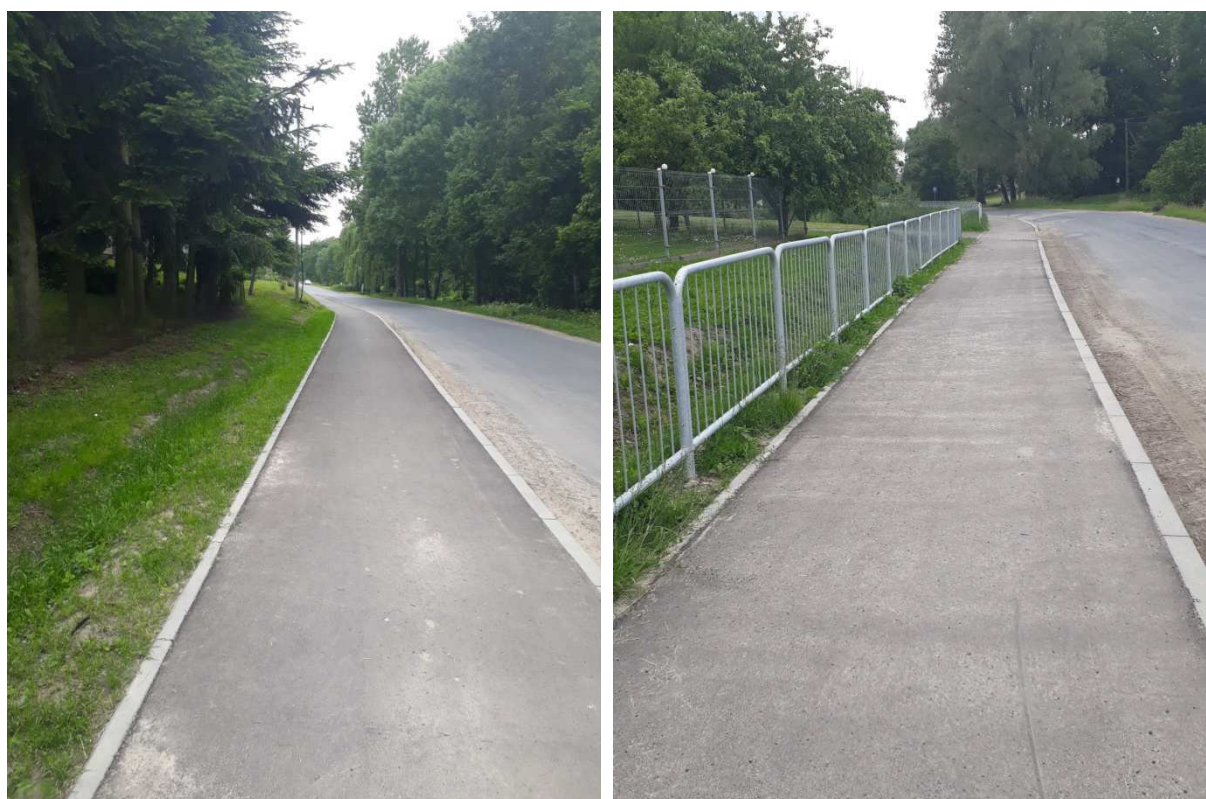
Zdjęcie 10 i 11 Budowa chodnika przy drodze powiatowej w Gielczwi Drugiej
