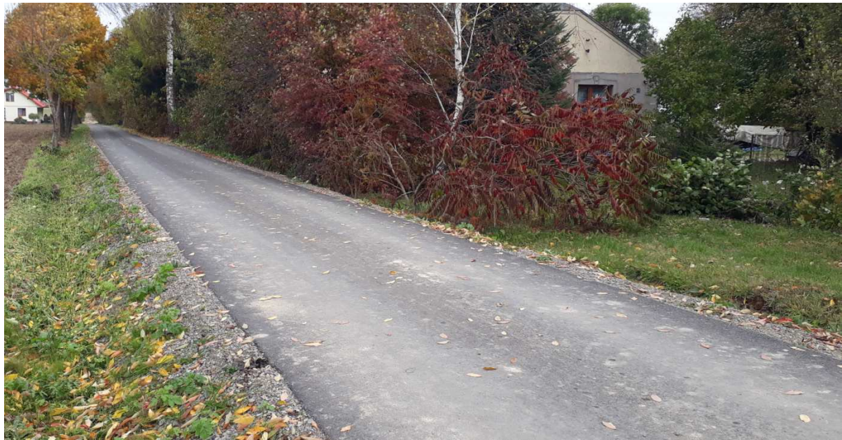
Zdjęcie 6. Modernizacja drogi wewnętrznej w miejscowości Giełczew Kolonia
