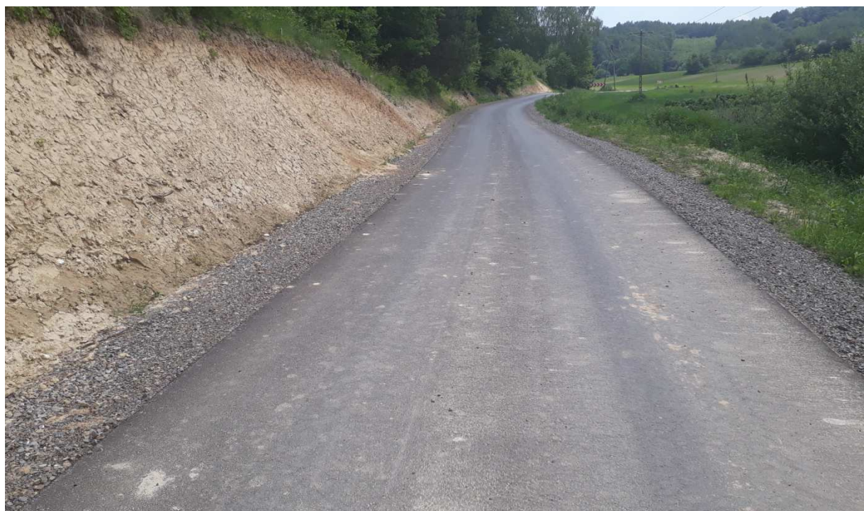
Zdjęcie 9. Przebudowa drogi gminnej nr 112582L w miejscowości Biskupie-Kolonia
