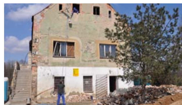
Pod koniec marca ruszyły prace remontowe na świetlicy wiejskiej w Krukowie
