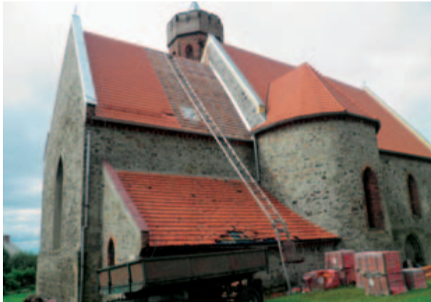
Prace remontowe w zabytkowym kościele w Pożarzysku potrwać do końca sezonu wakacyjnego.
