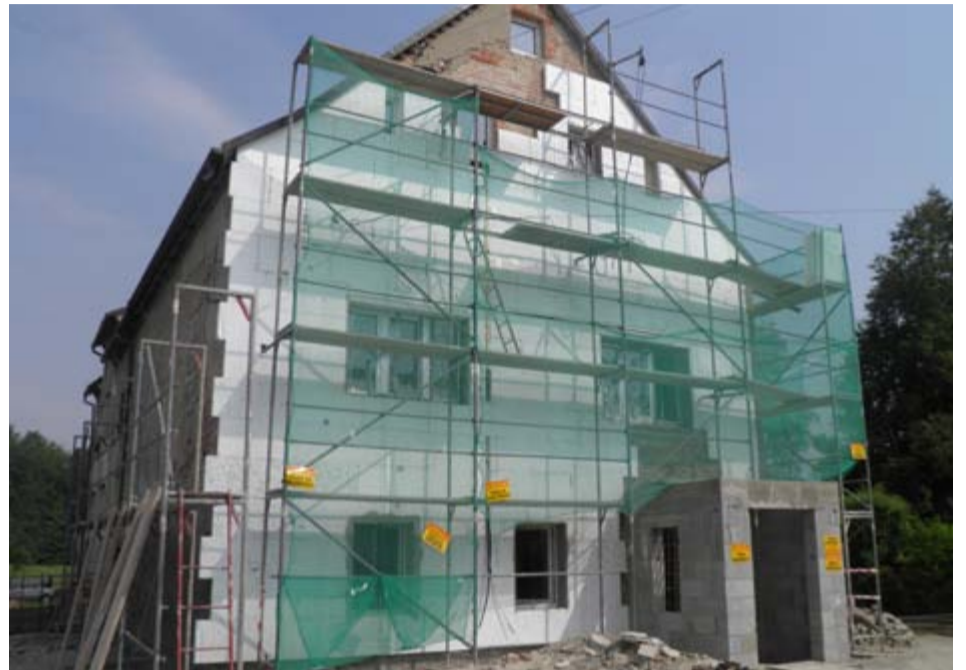
Prace remontowe i modernizacyjne na świetlicy wiejskiej w Krukowie nabierają coraz większego tempa.
