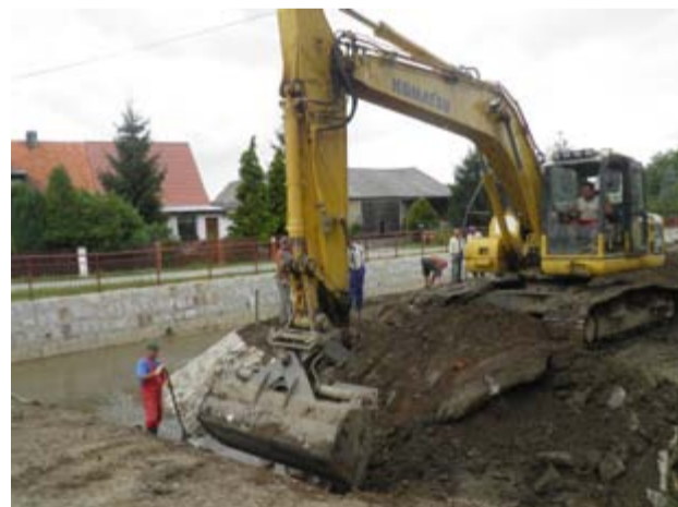
Prawdopodobnie do października 2014 roku potrwać prace remontowe potoku Tarnawka. Inwestycja prowadzona jest na terenie Bukowa i Imbramowic oraz pobliskiej wsi Dzikowa.
