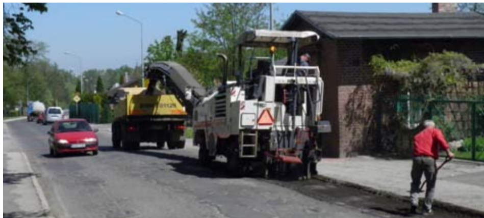
Główna ulica w Żarowie została wyremontowana na odcinku od sali widowiskowo-sportowej do jednostki Ochotniczej Straży Pożarnej. Remont ulicy Armii Krajowej w Żarowie rozpoczął się w okresie wiosennym.
