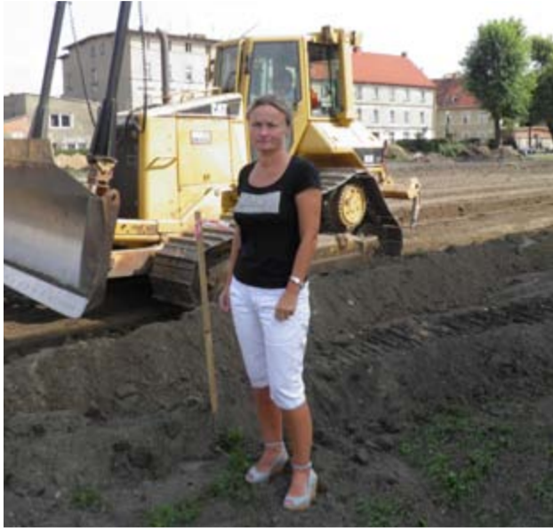
Prace przy budowie nowego boiska lekkoatletycznego przy żarowskiej podstawówce rozpoczęły się pod koniec sierpnia. Z nowoczesnego obiektu najmłodszy korzystają już w październiku.
