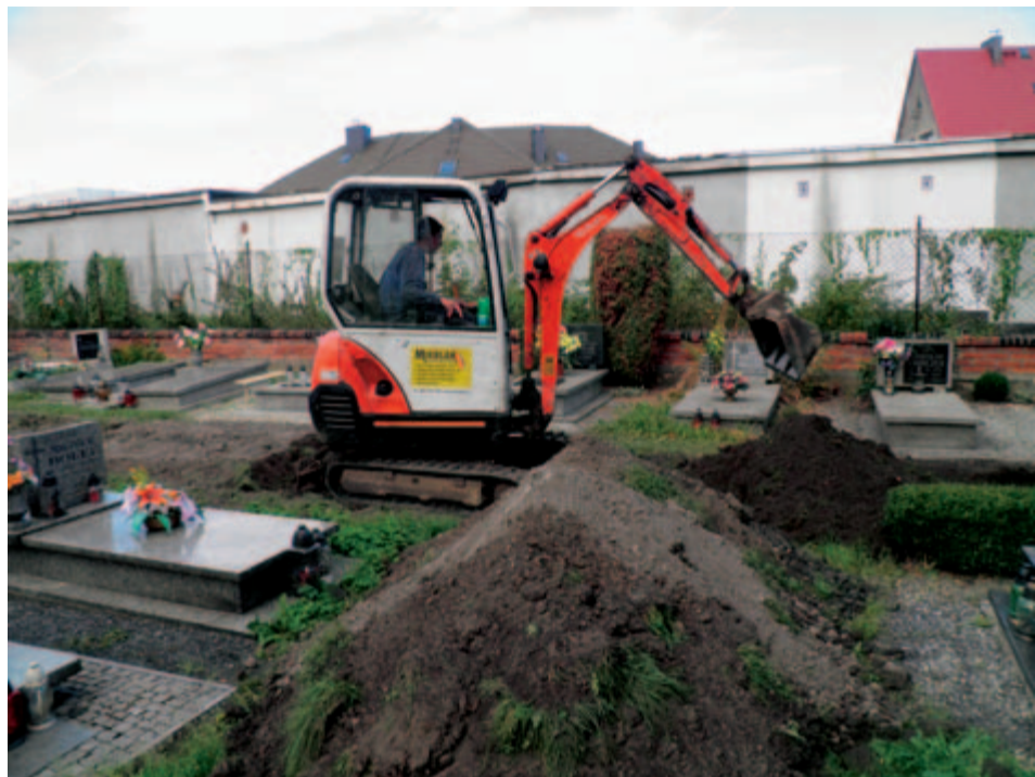
W ubiegłym roku wykonane zostały alejki na terenie starej części cmentarza w Żarowie. Wyposażono również cmentarną kaplicę w nowy sprzęt nagłaśniający. W tym roku wykonany zostanie kolejny etap prac na żarowskim cmentarzu.
