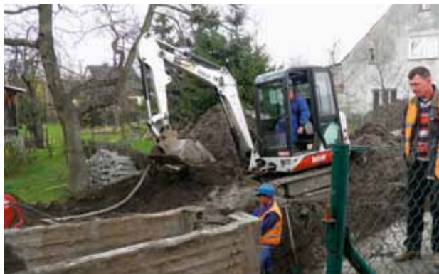
W pierwszym etapie budowy kanalizacji zostanie wykonana kanalizacja tłoczna i grawitacyjna w Bożanowie. Z uwagi na modernizację dróg dojazdowych w Wierzbnej, prace remontowe przy budowie kanalizacji trwają teraz przy ulicy Wąskiej, Łąkowej i Ogrodowej.
