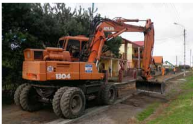
Tam, gdzie wykonano już prace remontowe w Łażanach, Kalnie i Pożarzysku mieszkańcy cieszą się z nowej nawierzchni drogowej. W remoncie są teraz drogi dojazdowe do gruntów rolnych w Mrowinach i Wierzbnej.
