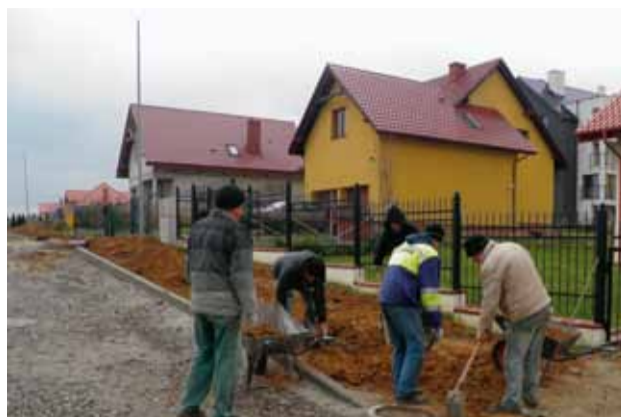
Nowy chodnik i oświetlenie, które powstają przy ulicy Księżnej Jadwigi w Żarowie poprawią bezpieczeństwo mieszkańców tego osiedla
