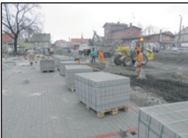
Prace remontowe targowiska przy ul. Dworcowej w Żarowie ruszyły pełną parą. Już niebawem to miejsce, w bardziej atrakcyjnej i wygodnej formie znów tętnić będzie życiem.
