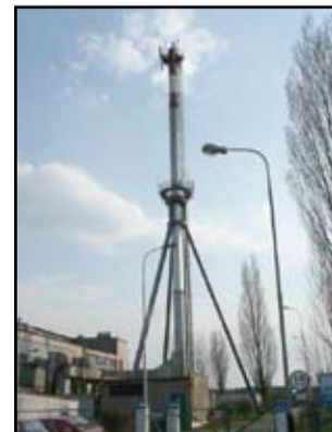
Właścicielem ciepłowni przy ul. Łokietka w Żarowie do 2013 roku było Przedsiębiorstwo Energetyki Ciepłej w Wałbrzychu. Od 1 stycznia nowym dostawcą ciepła jest Agencja Poszanowania Energii i Usług Energetyczno-Górnictwowych „ENMAG-EG”. Operatorem technicznym ciepłowni została spółka ZUT w Stroniu Śląskim, w której niemal 100 procent udziałów posiada firma „ENMAG-EG”.
