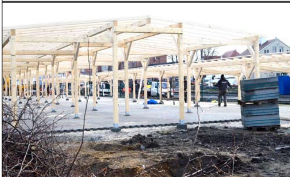
Prace remontowe przy modernizacji żarowskiego targowiska nabierają coraz większego tempa. Tak nowoczesne targowisko stanie się wizytówką Żarowa.
