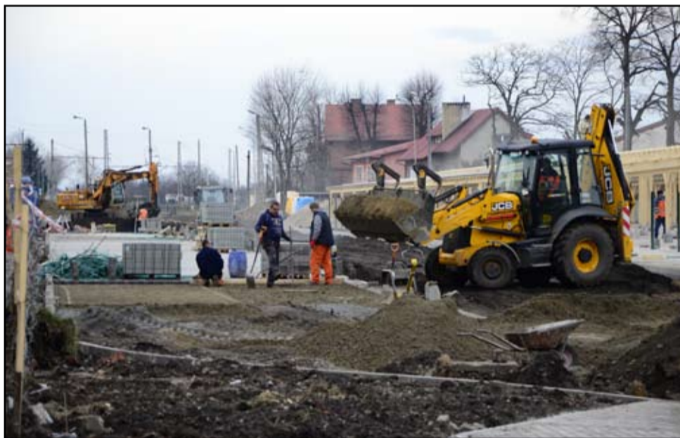
Na gruntowy remont targowiska gmina Żarów pozyskała pół miliona złotych z Programu Rozwoju Obszarów Wiejskich. W sumie, inwestycja pochłonie 850 tysięcy złotych.
