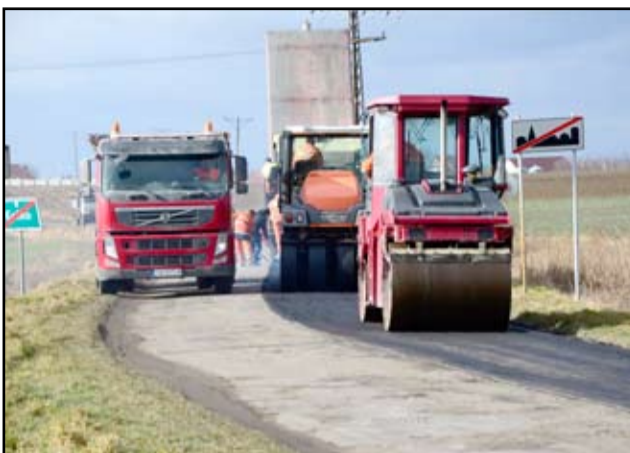
Budowa kanalizacji to jeden z największych projektów prowadzonych w gminie Żarów. Zakres prac jest szeroki i wiąże się również z robotami ziemnymi na odcinkach istniejących dróg. Po ułożeniu rur kanalizacyjnych firma remontowa w każdej miejscowości, w której budowana jest nowa kanalizacja odtwarzać będzie naruszone nawierzchnie drogowe. Tak jak to miało miejsce na odcinku drogi Bożanów-Kalno.
