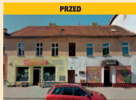
Tak przed remontem wyglądał budynek przy ul. Armii Krajowej 47 w Żarowie
