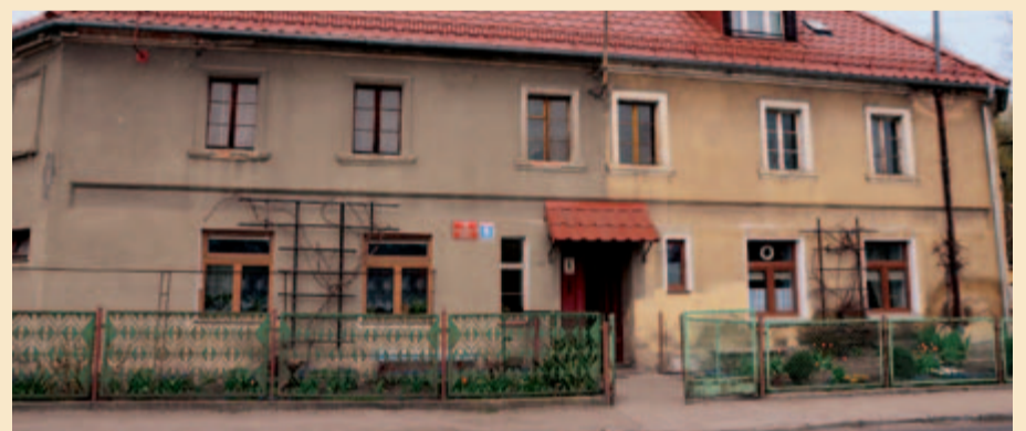
Po remoncie budynek przy ul. Strzegomskiej 6 w Łazanach ma nowy dach. W planach gminy i mieszkańców jest jeszcze wykonanie nowej elewacji.
