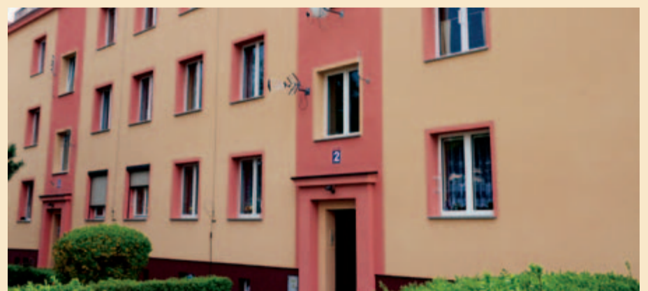
Nowy wygląd zyskał budynek przy ul. Rybackiej 2-2a w Żarowie. Tutaj również wykonana została nowa elewacja.
