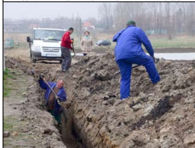
Zakończyły się już prace przy rozbudowie sieci wodociągowej w Mrowinach. Wciąż także nie brakuje chętnych do budowy przyłączy dla nowych budynków.
