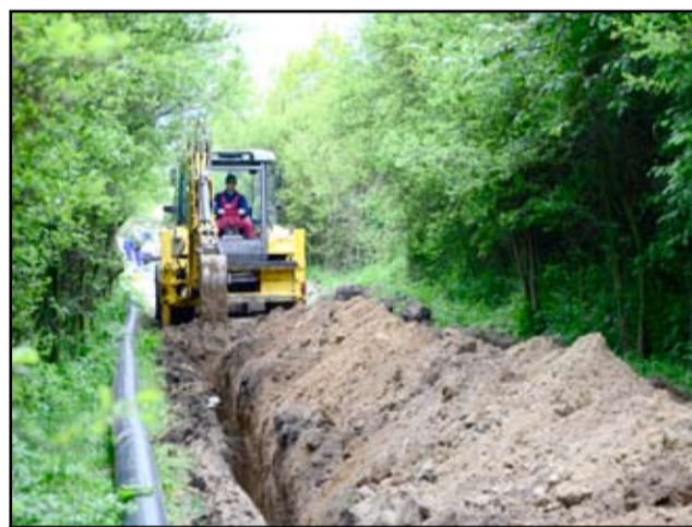
Żarowski Zakład Wodociągów i Kanalizacji systematycznie rozbudowuje sieci wodociągowe na terenie całej gminy. Rozbudowane sieci wodociągowe mają zapewnić dostęp do wody dla nowych terenów inwestycyjnych.
