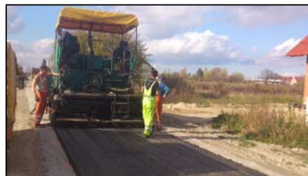
Niebawem z nowych nawierzchni drogowych będą mogli cieszyć się mieszkańcy kolejnych miejscowości. Remont rozpocznie się tam początkiem jesieni.
