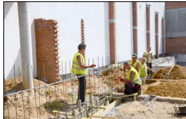
Według zapewnień wykonawcy budynek obiektu basenowego do końca roku ma zostać przykryty dachem. Prace remontowe wewnątrz budynku rozpoczną się początkiem przyszłego roku.
