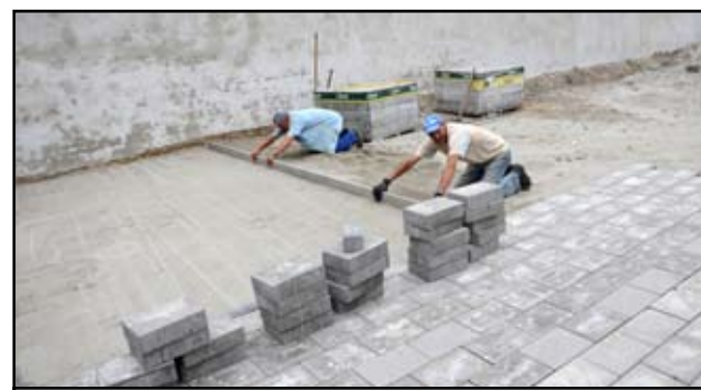
Zniszczony parking przy ul. Mickiewicza w Żarowie był częstą bolączką kierowców.
