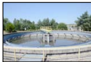
Dzięki budowie nowej suszarni ilość osadów zmniejszy się o ponad tysiąc ton w ciągu roku.
