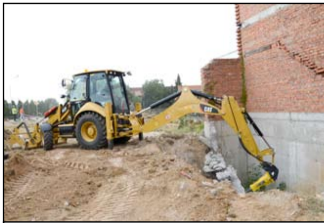
Pierwsze maszyny wjechały na plac budowy początkiem lipca.
