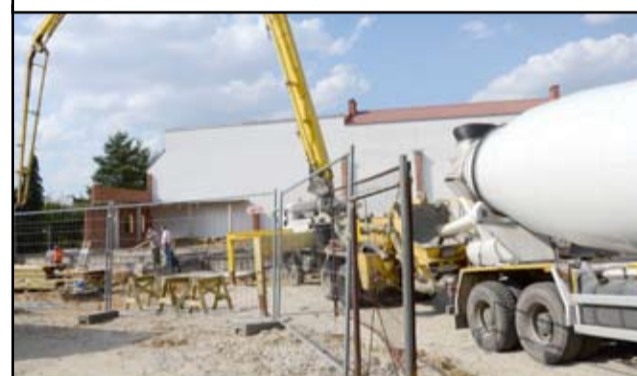
Budowa basenu w Żarowie to największa sportowa inwestycja. Jego budowę przygotowano od dawna.
