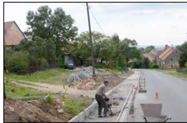
Prace remontowe trwają również przy budowie nowego chodnika w Imbramowicach.
