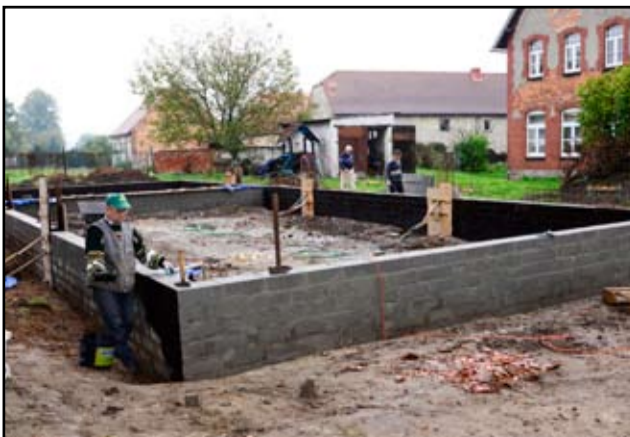
„Rośnie” również nowy budynek sali w Mrowinach. Wedle zapewnień firmy już w listopadzie budynek ma zostać przykryty dachem.
