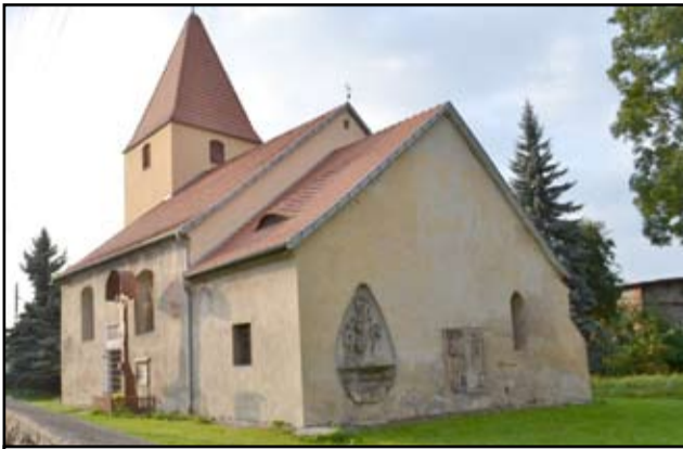
Zabytkowy kościół w Łażanach wymagał kapitalnego remontu.
