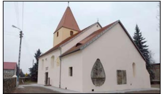
Tak, po remoncie prezentuje się kościół pod wezwaniem Bożego Ciała w Łażanach. Na jego modernizację Stowarzyszenie Miłośników Łażan „Przyjazna Wieś” pozyskało darowiznę w wysokości 49 tysięcy złotych.
