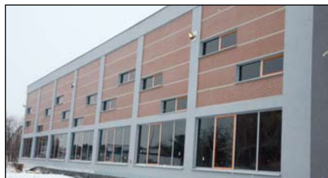
Widok budynku basenowego z jego zewnętrznej strony.
