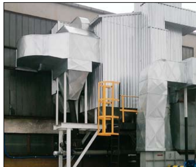
Tak wygląda nowa instalacja odpylania spalin przy żarowskiej ciepłowni. Sezon grzewczy jeszcze się nie zakończył, a nad kotłownią dziś nie widać już unoszących się kłębow dymu, tak jak to było jeszcze kilka miesięcy temu.
