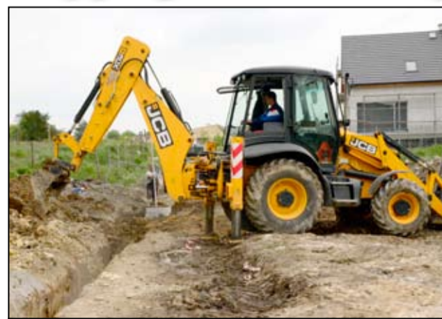
Ostatni etap budowy sieci wodociągowej przy ul. Parkowej w Żarowie zakończy się początkiem czerwca.
