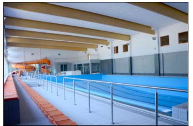
Na budowie basenu trwają w tej chwili jeszcze drobne prace konserwatorskie. Niebawem niecki basenowe wypełnione zostaną wodą.
