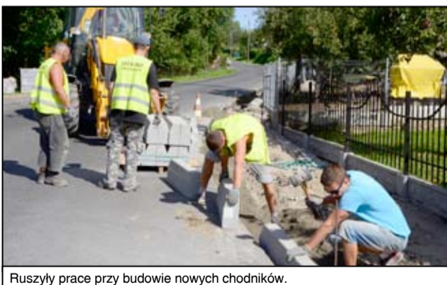
Ruszyły prace przy budowie nowych chodników.
