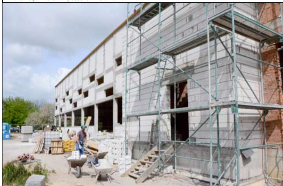
Najtrudniejsze prace budowlane zostały zrealizowane w 2015r. Obiekt zmieniał się z dnia na dzień.
