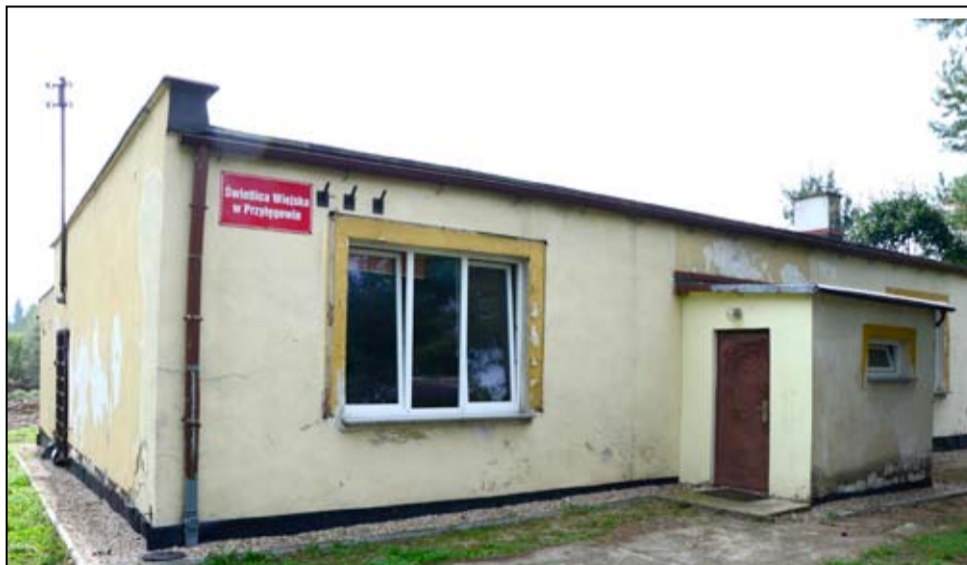
W złym stanie technicznym jest także obiekt w Przyłęgowie.
