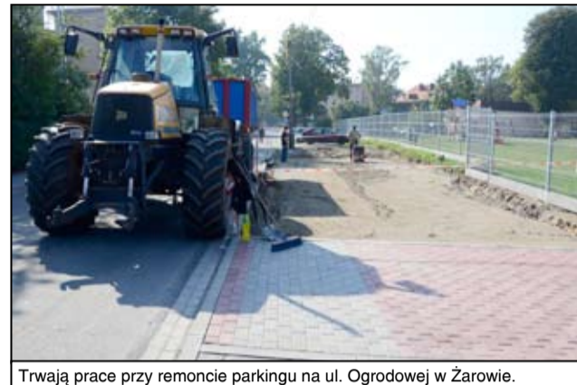
Trwają prace przy remoncie parkingu na ul. Ogrodowej w Żarowie.
