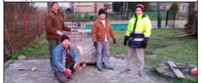
Wspólna praca przy budowie nowego pomieszczenia dla OSP Buków.
