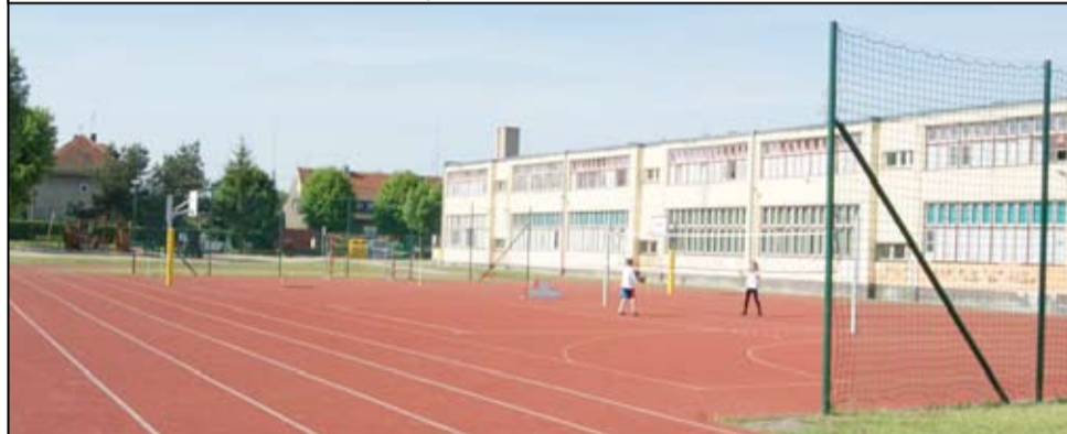
Termomodernizacja Szkoły Podstawowej w Żarowie. Koszt zadania to 1.245.575,99 zł, dofinansowanie z Regionalnego Programu Operacyjnego wyniesie 662.646,43 zł
