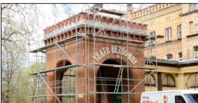
Prace remontowe przy remoncie dachu budynku przy ul. Zamkowej rozpoczęły się pod koniec lutego. I choć trochę przyczynią się do poprawy estetyki żarowskiego parku.
