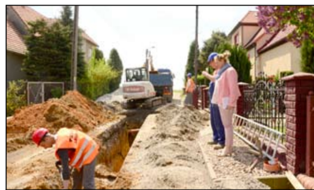
W tej chwili prace budowlane trwają przy ulicy Osiedlowej i Sportowej w Łazanach.
