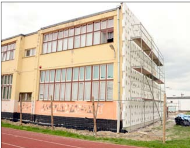
Prace przy termomodernizacji rozpoczęły się niedawno, a już dziś widać, jak bardzo ten remont był potrzebny.
