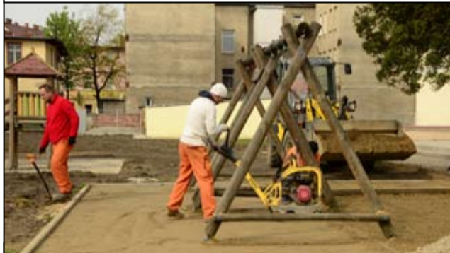
To kolejny etap prac przy ul. Ogrodowej w Żarowie.
