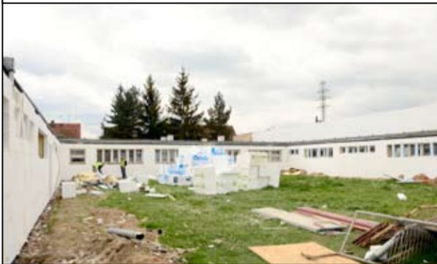
Na razie przyszkolny teren to plac budowy, na większe efekty musimy jeszcze trochę poczekać.
