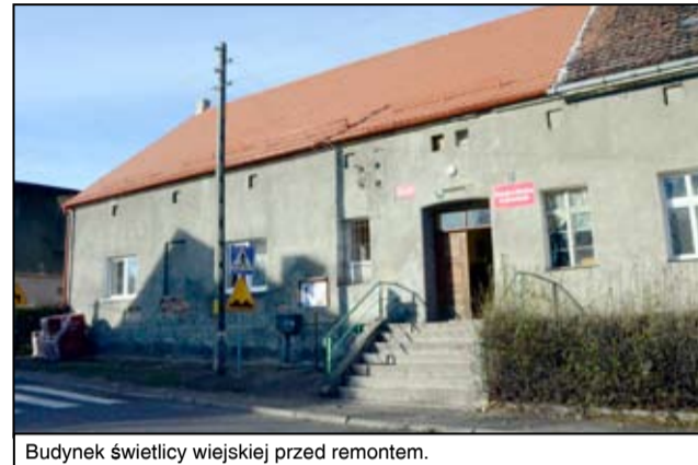
Budynek świetlicy wiejskiej przed remontem.
