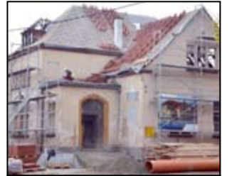
Trwa kapitalny remont budynku dworca kolejowego. Inwestycja, którą realizuje PKP S.A. potrwa do końca marca 2018 roku. Jej koszt to 6.184.440 złotych.
