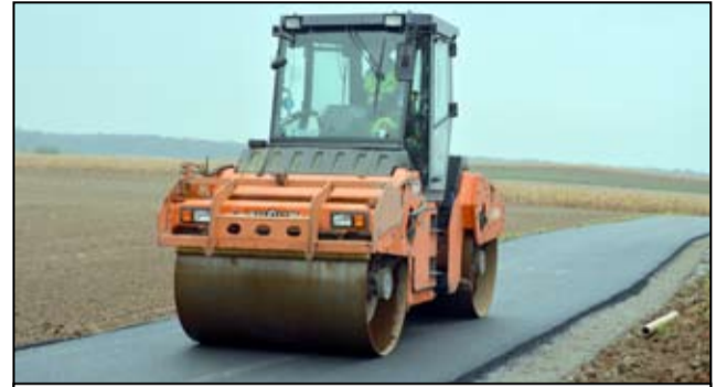
Nowa droga asfaltowa powstała przy cmentarzu parafialnym. Wizerunek zmieni tam również cały teren wokół cmentarza.
