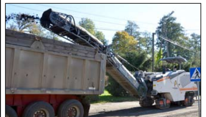
Inwestycja rozpoczęła się od zerwania starej nawierzchni asfaltowej w centrum wsi.
