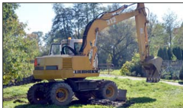
Obecnie prace realizowane są przy głównej przepompowni.
