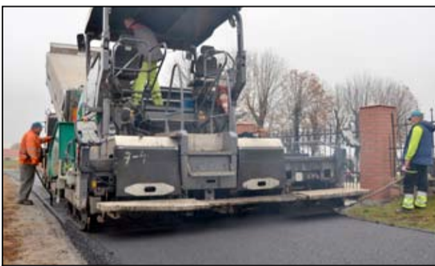
Zakończyły się już prace przy przebudowie drogi dojazdowej w Bukowie.
