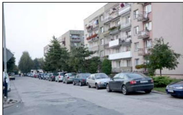
Tak jeszcze kilka dni temu wyglądała stara nawierzchnia z płyt betonowych przy ul. Łokietka w Żarowie.
