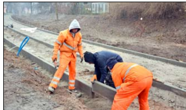
Prace ziemne i budowlane trwają także przy ul. Krasińskiego w Żarowie. Powstanie tam nowa ścieżka rowerowa, chodnik wraz z oświetleniem ulicznym i przebudowa parkingów.
