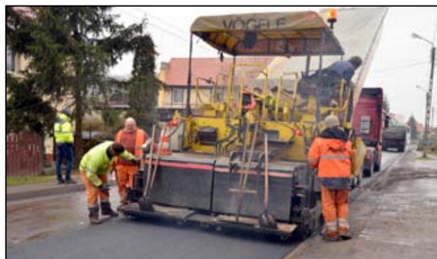
Odtworzenie nawierzchni drożowych kończy zadanie związane z budową kanalizacji w Łażanach.
