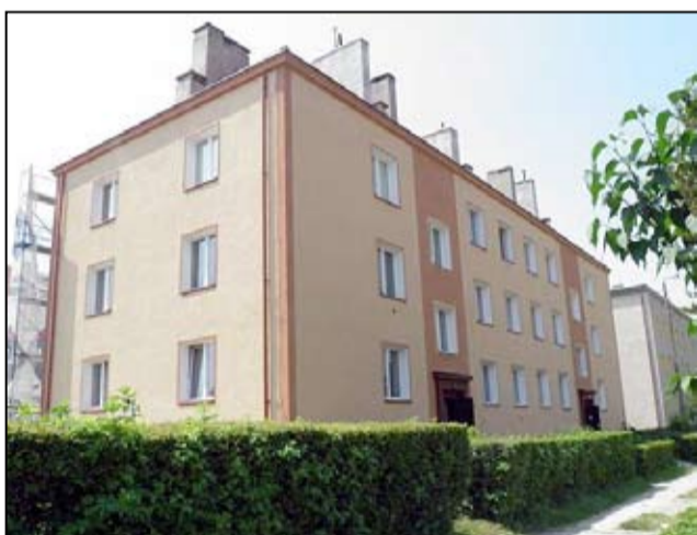
Rewitalizacja budynków wspólnot mieszkaniowych – 29 budynków (koszt zadania to kwota 3.271.979, 28 zł, w tym dofinansowanie 1.600.000,00 zł)
