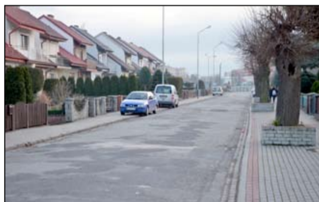
Rewitalizacja miasta i przebudowa dróg w Żarowie oraz zagospodarowanie terenów przestrzeni w mieście (dotyczy ulic: Dworcowa, Kopernika, Kwiatowa, Mickiewicza, Plac Wolności, Puszkina, Słowackiego, Sportowa, Wojska Polskiego, Zamkowa. Koszt zadania to kwota 2.625.616,00 zł, w tym dofinansowanie 1.816.168,00 zł)
