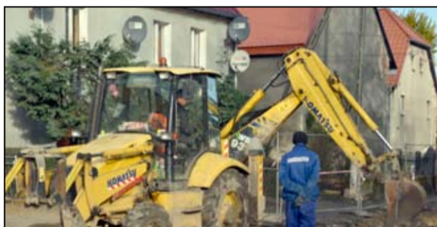
Budowa kanalizacji w Mrowinach (II etap ma potrwać do końca sierpnia 2018r., szacunkowy koszt zadania to kwota 4.500.000, 00 zł, planowane dofinansowanie to kwota 3.109.131,72 zł, w tym etapie zostanie skanalizowana pozostała część ulicy Wojska Polskiego aż do Żarowa)
