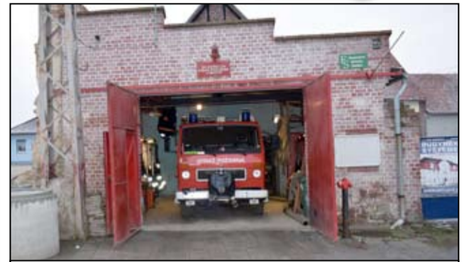
Budynek dotychczasowej remizy strażackiej jest stary i bardzo zniszczony.
