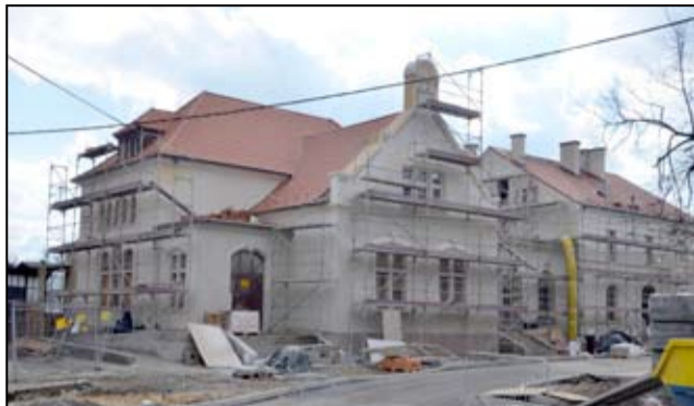
Budynek dworca kolejowego nabiera nowego wyglądu. Dzięki zrealizowanym pracom nie będzie już straszyl swoim wyglądem. Inwestycje w całości realizuje właściciel obiektu PKP. Remont pochłonie dokładnie 6.184.440 złotych. Prace mają zakończyć się w pierwszym kwartale 2018 roku.
