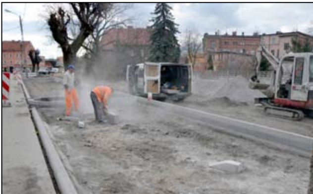
Przyspieszyły również prace przy budowie nowych ścieżek rowerowych, chodników i oświetlenia. Gotowe są już miejsca parkingowe od strony ulicy Dworcowej, z których korzystają mieszkańcy. Ścieżki powstają na razie przy ulicach: Krasińskiego, Armii Krajowej, Alei Korczaka, Wiejskiej, Nadbrzeżnej i Talowskiego. Łącznie na terenie miasta przybędzie dokładnie 8,20 kilometrów nowych dróg rowerowych.
