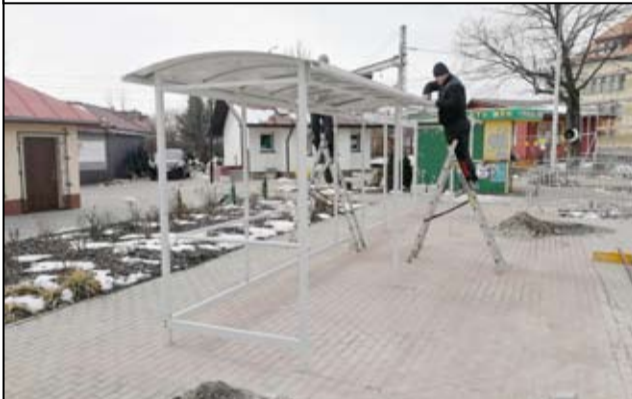
Przy Centrum Przesiadkowym też trwają jeszcze prace remontowe. Została zamontowana nowa wiata przystankowa wraz z wyposażeniem, a w następnej kolejności pojawią się jeszcze nowe stojaki rowerowe, kosze na śmieci oraz azyle drogowe
