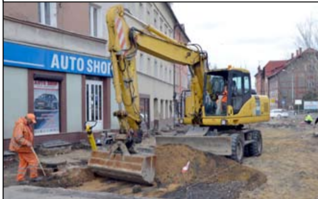
To jedna z kluczowych inwestycji realizowanych na terenie miasta. Budowa Zintegrowanego Centrum Przesiadkowego i przebudowa głównego skrzyżowania. Ostatnio prace pokrzyżowała drogowcom kapryśna pogoda, ale i tak inwestycje zlokalizowane na tym terenie nabrały tempa. Centrum Przesiadkowe przy ul. Dworcowej w Żarowie także zrealizowane jest już w znacznej mierze. Teraz przyszedł czas na budowę ronda, co mieszkańcy miasta mogą bacznie obserwować każdego dnia.
