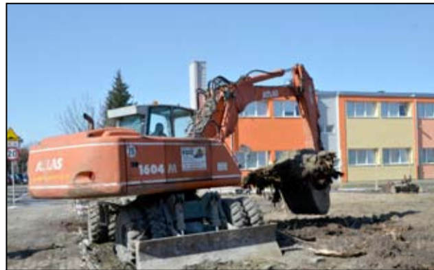
Rozpoczęły się także prace remontowe przy Szkole Podstawowej im. Jana Brzechwy w Żarowie. Trwa tam budowa pętli postojowej, co wpłynie na poprawę sytuacji komunikacyjnej przy ul. 1 Maja. Inwestycja potrwa do połowy maja. W ramach zadania wykonana będzie pętla postojowa dla samochodów osobowych o szerokości jezdni 4,5 m i chodnika o szerokości 2,0m o łącznej długości 40,48m. W tym celu przesunięte zostanie ogrodzenie szkoły oraz zdemontowany będzie stary plac zabaw, który znajduje się na terenie szkolnej placówki. Najważniejszym celem tego zadania jest przede wszystkim rozładowanie korków przed szkołą, co ma niestety dzisiaj miejsce. Samochody nie będą musiały cofać przy ograniczonej widzialności na długości ul. 1 Maja.
