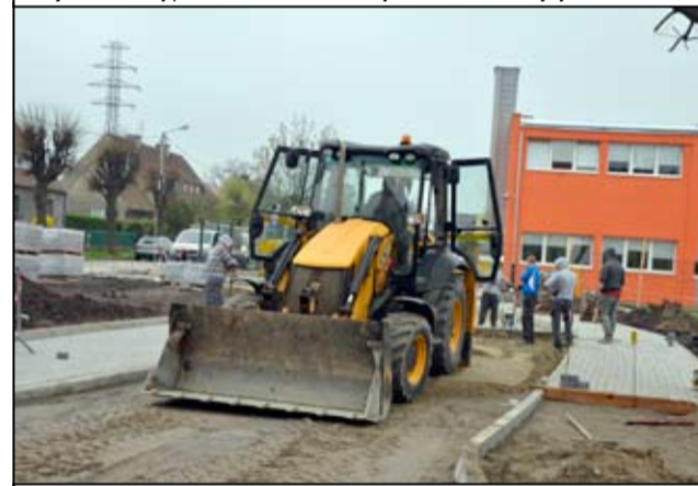
Dzięki budowie pętli postojowej poprawi się sytuacja komunikacyjna.
