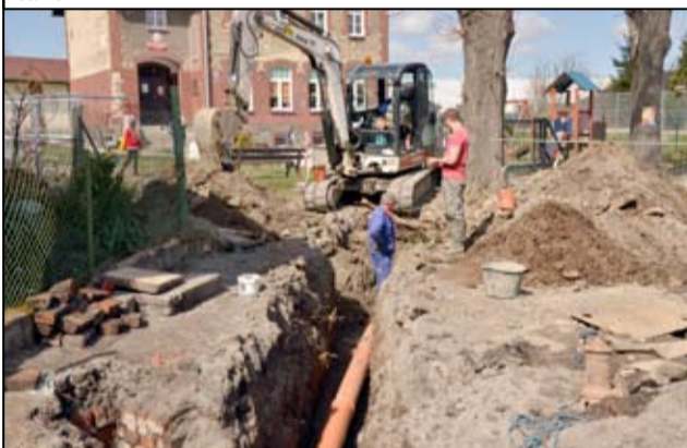
Jednym z ostatnich zadań w ramach pierwszego etapu będzie całkowite odtworzenie nawierzchni.
