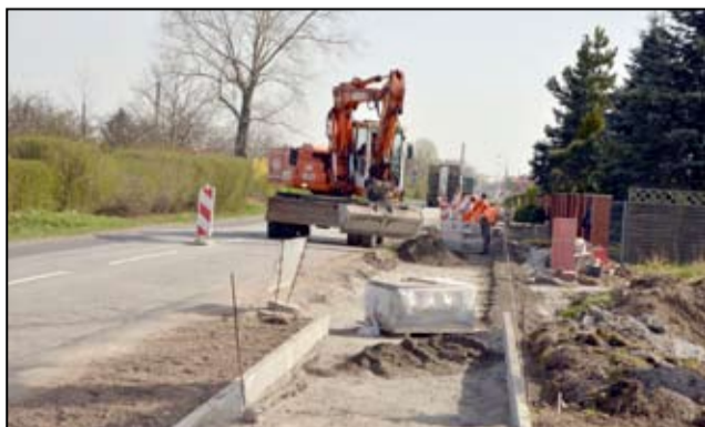
Powstająca ścieżka rowerowa przy ul. Wiejskiej w Żarowie.
