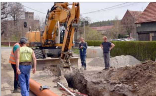
Pierwszy etap prac kanalizacyjnych w Mrowinach ma się zakończyć niebawem.
