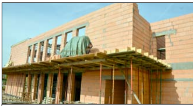
Nowy budynek żłobka, który powstaje przy Bajkowym Przedszkolu będzie się nazywał „Bajkowa Kraina”. Niebawem zostanie także ogłoszony konkurs na logo nowej placówki.
