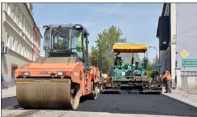
Ułożenie nowej warstwy asfaltowej przy skrzyżowaniu w centrum miasta to już kolejny zrealizowany etap tej inwestycji.
