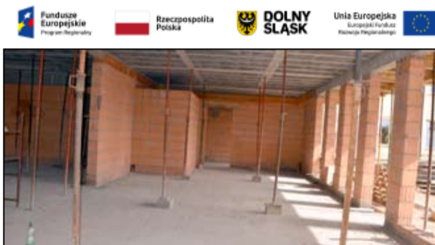
Mieszkańcy mogą obserwować inwestycję każdego dnia. I każdego dnia widać, że prace realizowane są w bardzo szybkim tempie.
