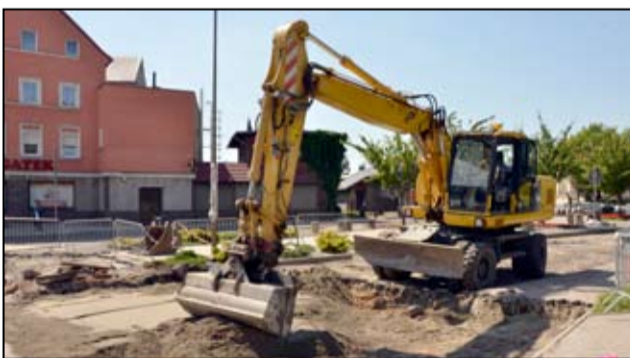
Niebawem droga przy ul. Dworcowej w Żarowie zyska nową asfaltową nawierzchnię.
