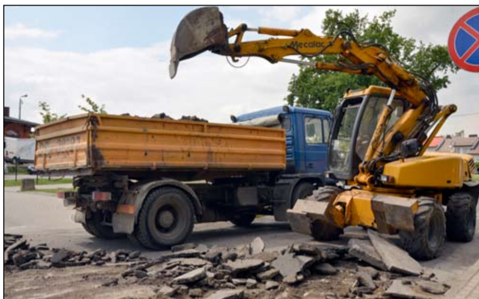
Inwestycja rozpoczęła się od zerwania starej warstwy asfaltowej.
