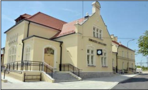
Wyremontowany budynek dworca PKP w Żarowie wygląda jak nowy. Ulica Dworcowa w Żarowie, gdzie powstało także zmodernizowane Centrum Przesiadkowe, zyskała nowy wizerunek.
