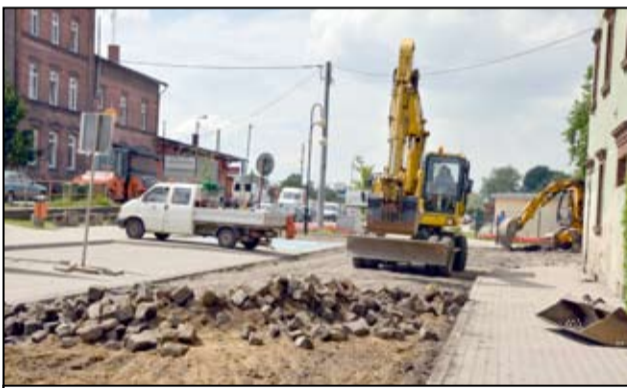
W związku z prowadzonymi pracami droga przy ul. Dworcowej została zamknięta. Zgodnie z podpisaną umową remont ma potrwać do końca lipca.
